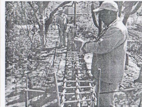
Armado de columnas C2. 30-oct-15
