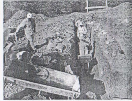
Inicio del colado de la Plantilla 17-oct-15
