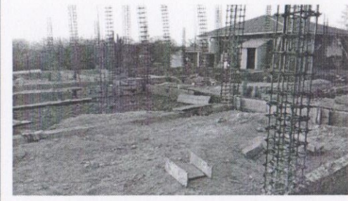
Relleno de material inerte 25-02-16
