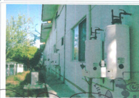
F5: Parapetone fachada posterior
