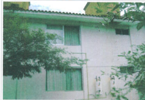
F2: Fachada posterior lado poniente
