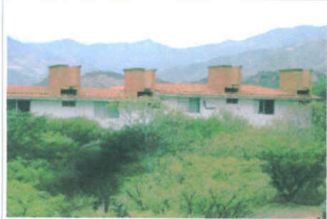
F1: Fachada posterior del Edificio
