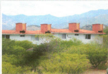
F1: Fachada posterior del Edificio
