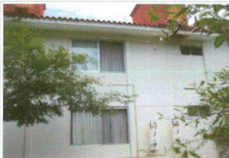
F2: Fachada posterior lado poniente
