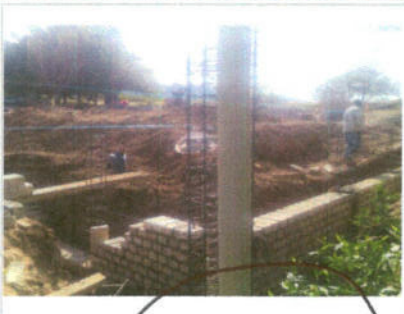
F3: Muro de cimentación, zapatas corridas y contratabres, cadenas y castillos
