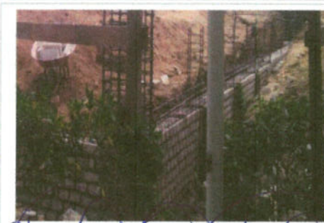
F5: habilitado y armado de acero de refuerzo en columnas y vigas de cimentación.
