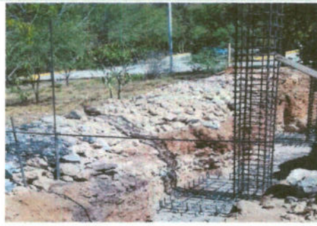
F2: Acero de refuerzo en columnas en zapatas aisladas y colado de plantilla
