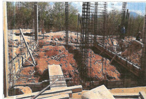
F2: Colado de la cimentación.
