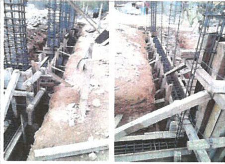
F1: Habilitado y cobrado de acero de refuerzo y cimbrado de cimentación.
