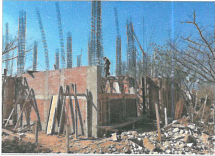
F1: Colado de columnas en P.Baja y muros de 14 cm.
