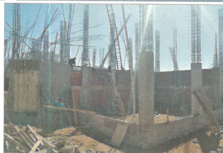
F4: Colado de columnas en P.Baja y muros de 14 cm.
