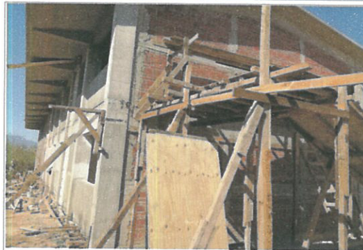
F2: Aplanado fino y caja de concreto.
