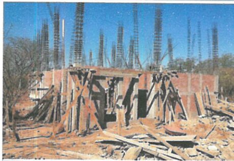
F2: Colado de columnas en P.Baja y muros de tabique de 14 cm.
