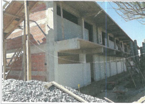
F1: Aplanado fino, murete y relleno en banqueta.
