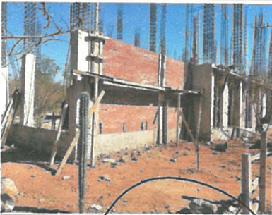
F3: Colado de columnas en P.Baja y muros de 14 cm.
