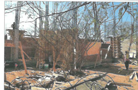
F5: Colado de columnas en P.Baja y muros de 14 cm.
