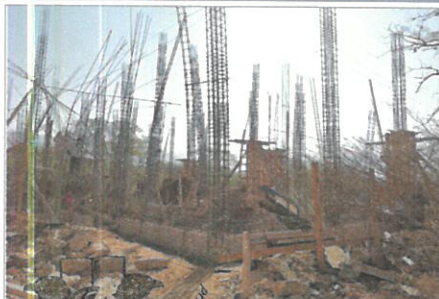
F4: acero de refuerzo en estructuras.
