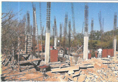
F2: Colado de columnas en P.Baja y muros de tabique de 14 cm.
