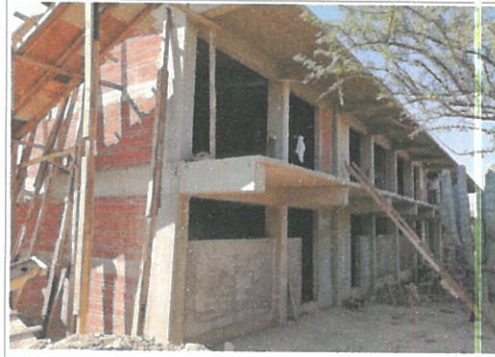
F1: Colado de losa de azotea, aplomado de muros de 14 cm.
