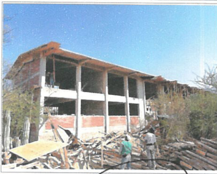
F3: Descimbrado de traveses y volado de losa de azotea, muro de tabique de 14 cm.
