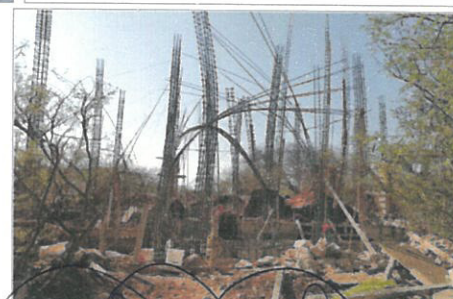
F5: acero de refuerzo en estructuras.
