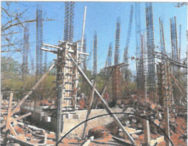
F3: acero de refuerzo en estructuras y cimbrado de columnas en P. baja
