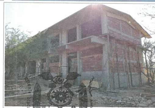
F4: Descimbrado de traveses y volado de losa de azotea, muro de tabique de 14 cm.
