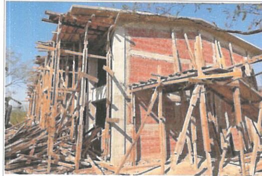
F2: Descimbrado de traveses y volado de losa de azotea.
