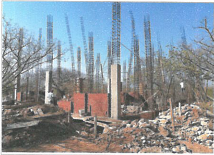
F1: colado de cimentación, colado de columnas en P.Baja y muros de 14 cm.
