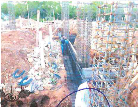
F3: ACERO DE REFUERZO EN CIMENTACIÓN Y ESTRUCTURAS
