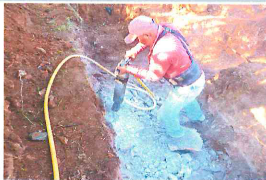
F2: EXCAVACIÓN EN TERRENO TIPO C
