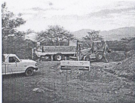
Excavación con maquinaria 24-sep-15
