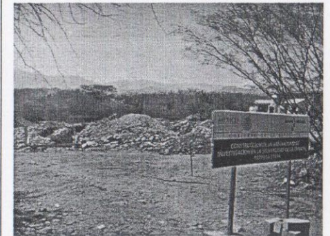
Afine de talud y fondo. 07-oct-15
