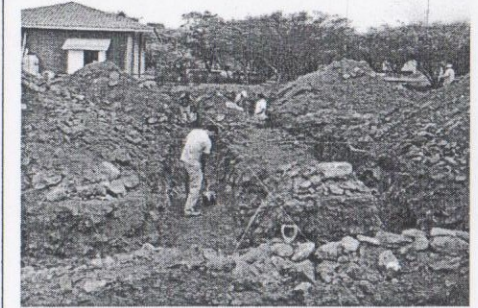
Excavación a mano y afine de fondos y talud 29-sep-15
