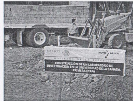
Excavación con maquinaria 24-sep-15
