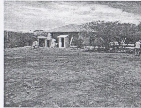
Despalme del terreno 14-sep-15
