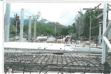
F5: armado de acero para periferia y perimetro.
