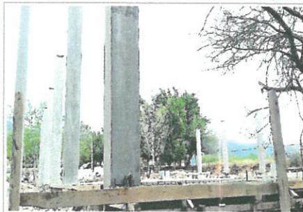
F1: concreto armado en columnas
