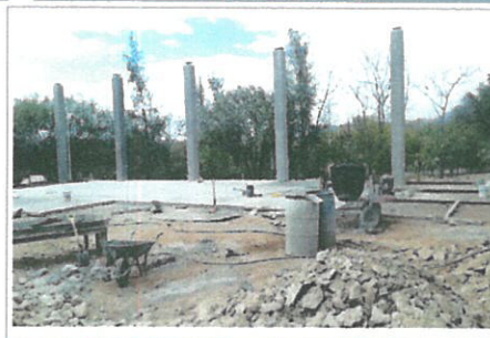
F4: retiro de escombros del interior de la superficie de cancha.
