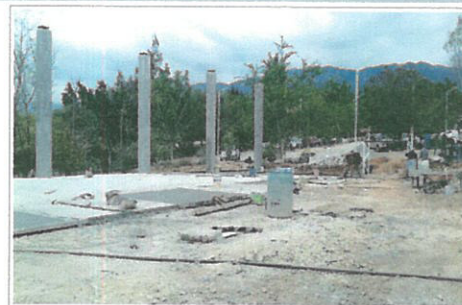
F2: piso de concreto 1'x200 kg/cm2
