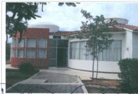
F5: Fachada Centro de Idiomas
