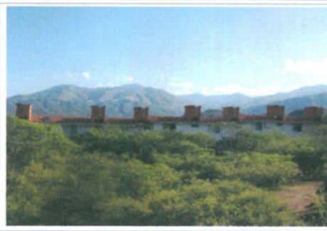
F4: Fachada posterior
