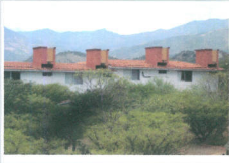
F1: Fachada posterior del Edificio
