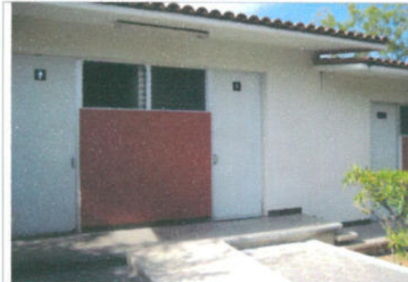
F4: Puertas CAPPCE del edificio de Aulas
