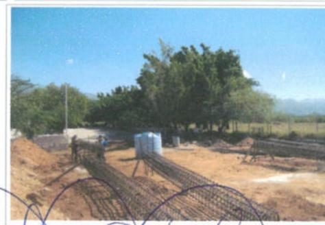
F5: habilitado y armado con acero de refuerzo en columnas
