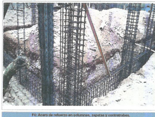
F4: Acero de refuerzo en columnas, zapatas y contratabres.
