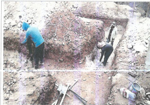
F2: Excavación en terreno tipo B o C
