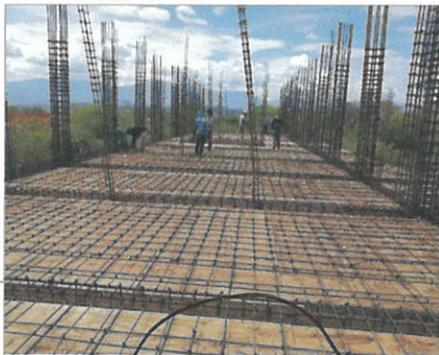
F3: Cimbrado de losa dentro de refuerzo en traves, entornas, cañillas y juntas de refuerzo.
