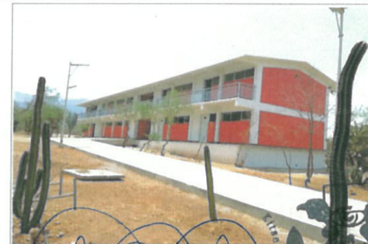
F3: Fachada Occidental
