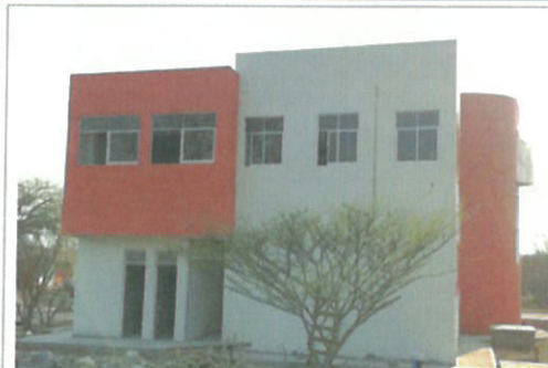
F2 Colofno de losa de entresuelo, columnas, casillitas, muro de tabique de 14 cm
