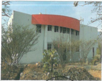
F3 Fachada posterior y terraza de obra
