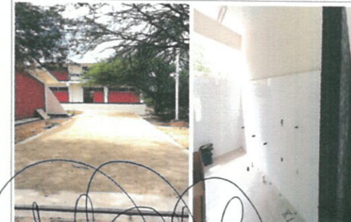
F5: OBRA EN PERSPECTIVA SUR
