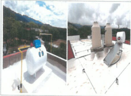
F1. TANQUE ESTACIONARIO Y CALENTADOR SOLAR
