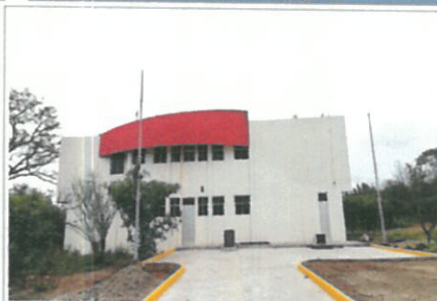
F4. PATIO DE MANOBRAS
