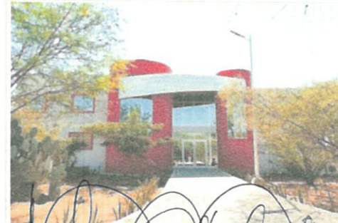
F5: Fachada exterior del edificio
