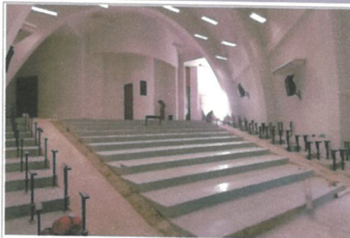
F2: RETIRO DE FORRO EN PISO
