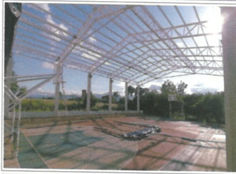
F1: ARMADURAS A1 Y P1
