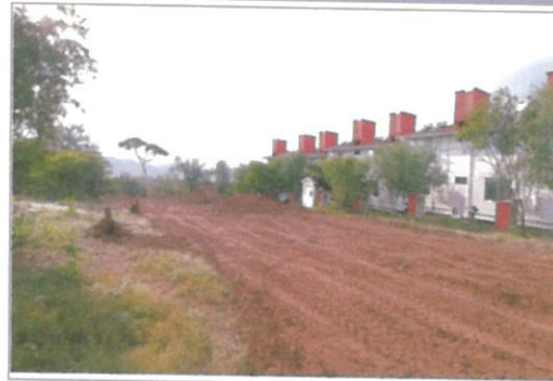
F2: LIMPIEZA Y DESPALME
