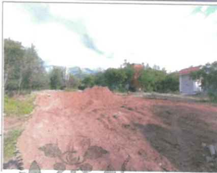
F3: LIMPIEZA Y DESPALME
