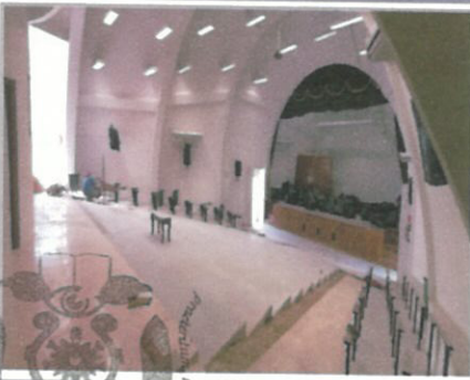
F3: REMOCIÓN DE PISO
