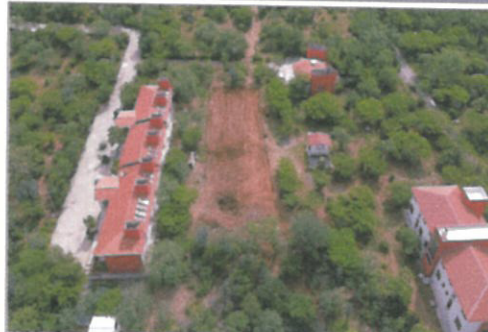
F4: LIMPIEZA Y DESPALME
