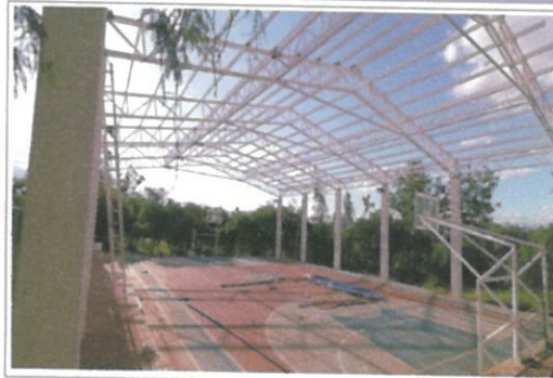
F2: ARMADURAS A1 Y P1
