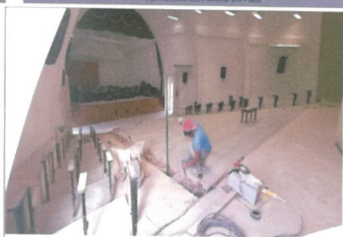
F4: DEMOLICIÓN DE PISO
