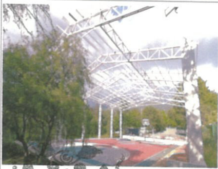
F3: ARMADURAS A1 Y P1
