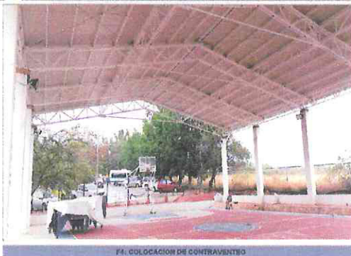
F4. COLOCACION DE CONTRAVIENTO
