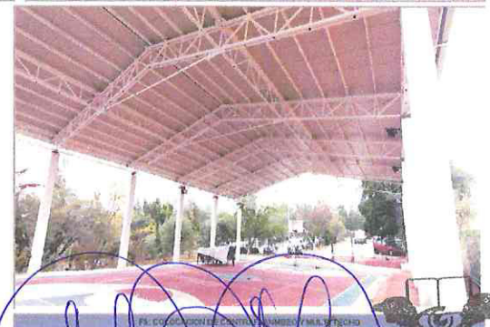
F5. COLOCACION DE CONTRAFLANJEO Y MULTYTECHO
