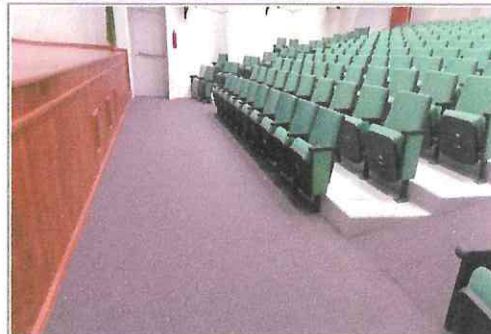
F4: COLOCACIÓN DE ALFOMBRA
