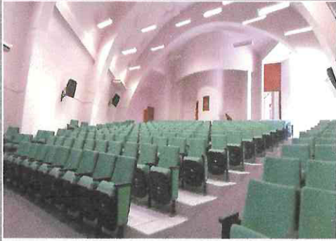
F1: MONTAJE DE BUTACAS
