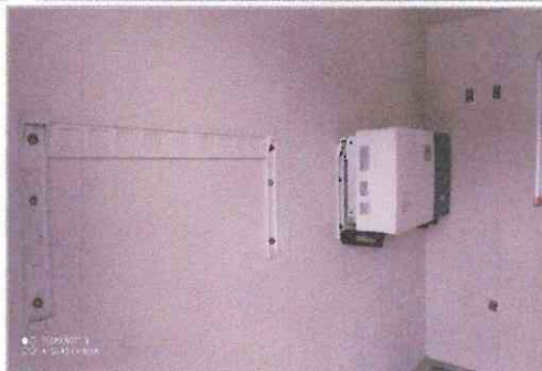
F4: INSTALACION DE INVERSOR
