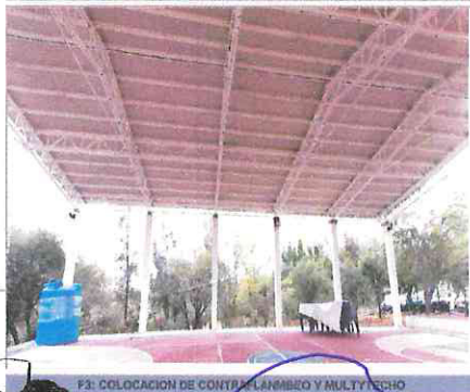
F3. COLOCACION DE CONTRAFLANJEO Y MULTYTECHO
