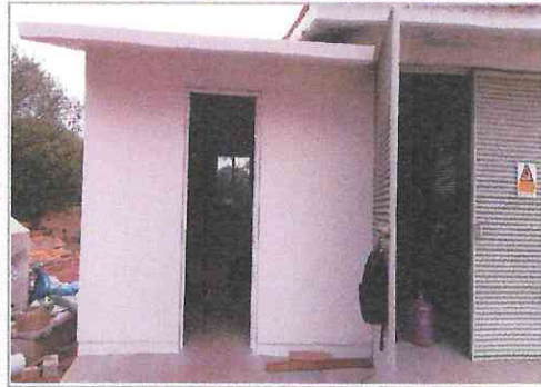
F1: CASITA DE INVERSORES
