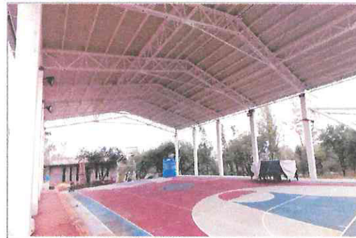
F2. COLOCACION DE CONTRAFLANJEO Y MULTYTECHO
