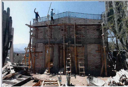
F2: Habilitado de acero de refuerzo y cimbra en trabes.
