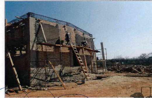
F5: Colado en muros estructura de Planta Alta.
