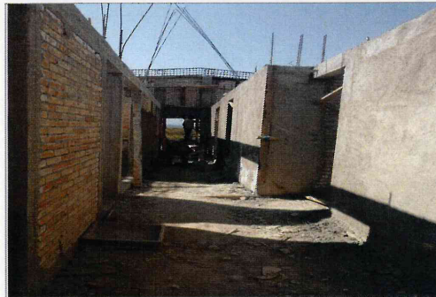
F4: Colado en muros de Planta Baja.
