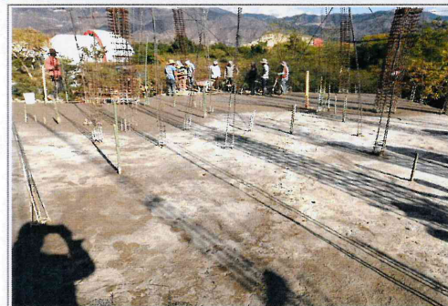
F4: Colado de losa de Entrepiso.
