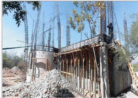
F1: Habilitado de acero de refuerzo losa y trabes.
