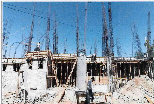
F2: Habilitado de acero y cimbra en losa y trabes.
