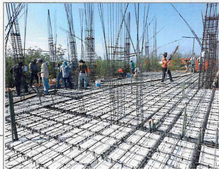
F3: Acero de refuerzo en losa reticular y unidireccional.
