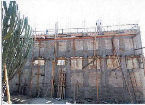
F1: Habilitado de acero de refuerzo y cimbra en trabes.
